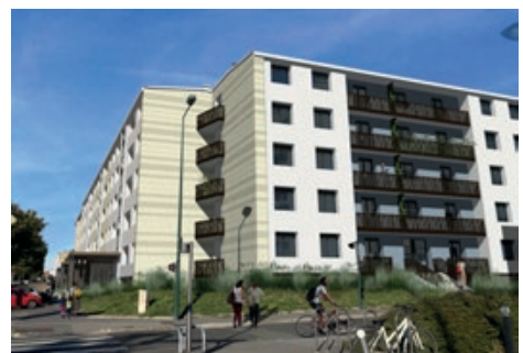
Projection après les travaux de rénovation
