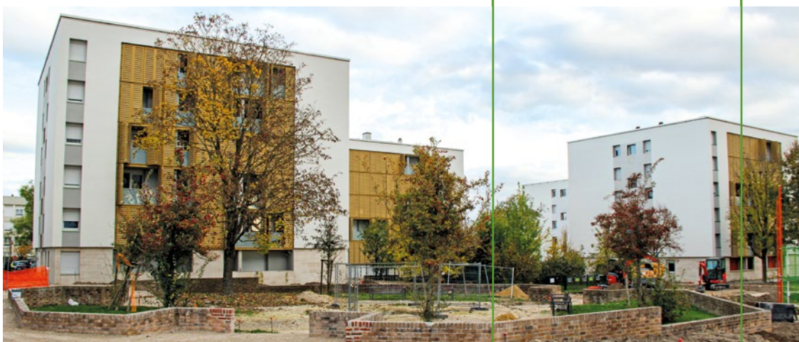
Rénovation rue du Dr Schweitzer
